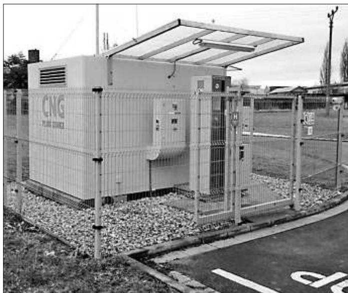
Plnicí stanice MJ Compact Plus s výdejním stojanem (ilustrační foto)
