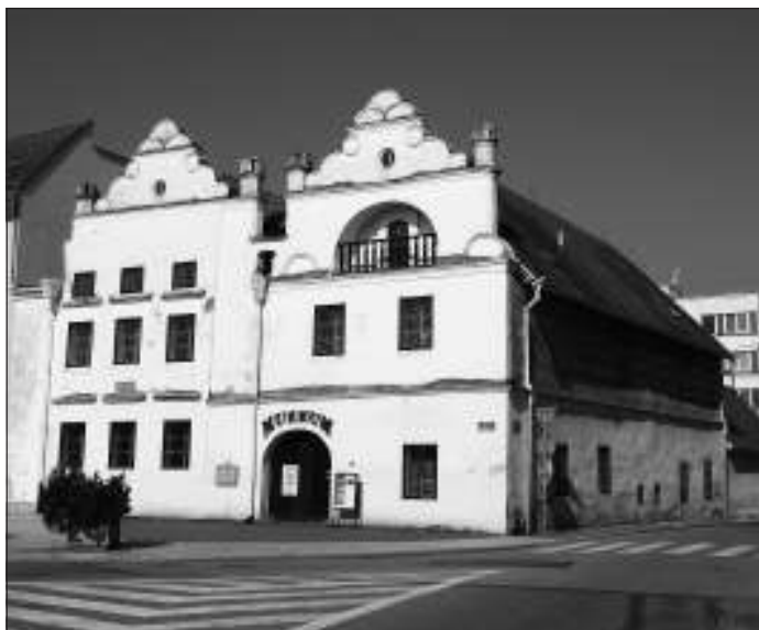
rok 2013 před rekonstrukcí
