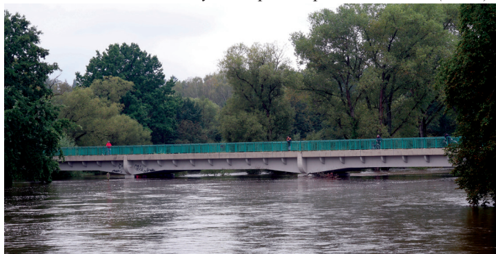
Pohled na Bechyňský most od jezu (17. 9.)
