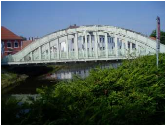
železobetonový most přes Černovický potok
