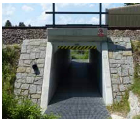
Propustek s podchodem u Andělské stoky
