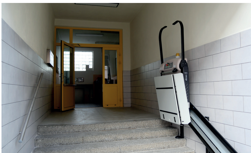
V srpnu byla dokončena oprava vnějšího soklu na budově ZUŠ Soběslav. Vybudován byl také bezbariérový vstup, foto: archiv.
