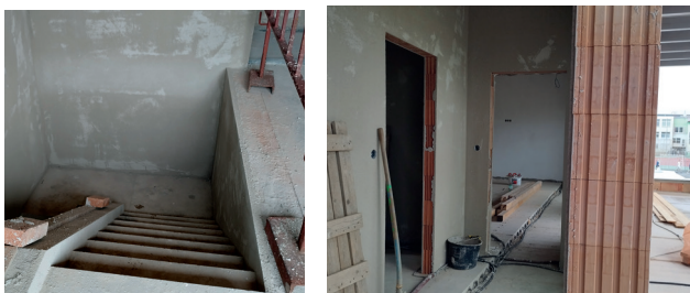
Přístavba nového zázemí sportovního zařízení vedle fotbalové tribuny. Foto: archiv
