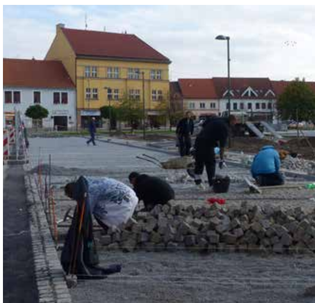
Pokládka dlažby na parkovišti na severní straně centrální plochy náměstí, naproti KB
