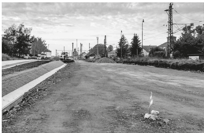
Zemní práce nedaleko železniční stanice Soběslav, podél stavebnin PRO-DOMA
