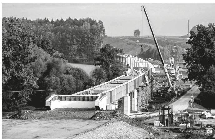
Velká eskatáda ve směru od tunelu do Sedlečka
