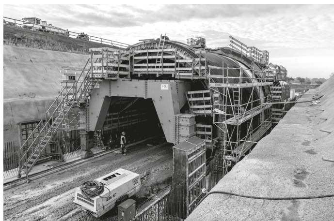
Výstavba Zvěrotického tunelu
