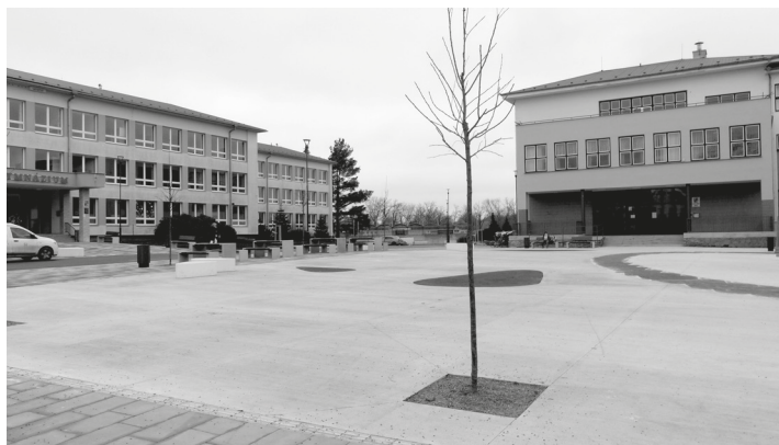
Předprostor škol ZŠ E. Beneše a gymnázia po dokončení
