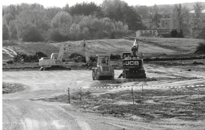
Stavební práce probíhaly již v říjnu v lokalitě před nájezdem na dálnici D3 z ulice Tyršova
