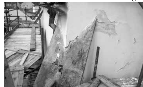
Oprava fasády kostela sv. Petra a Pavla
