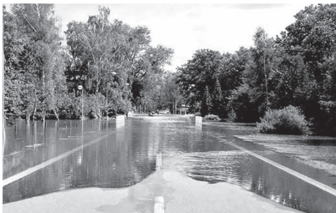
Voda na silnici E55 zablokovala dopravu, 13. 8. 2002 (nahore)
